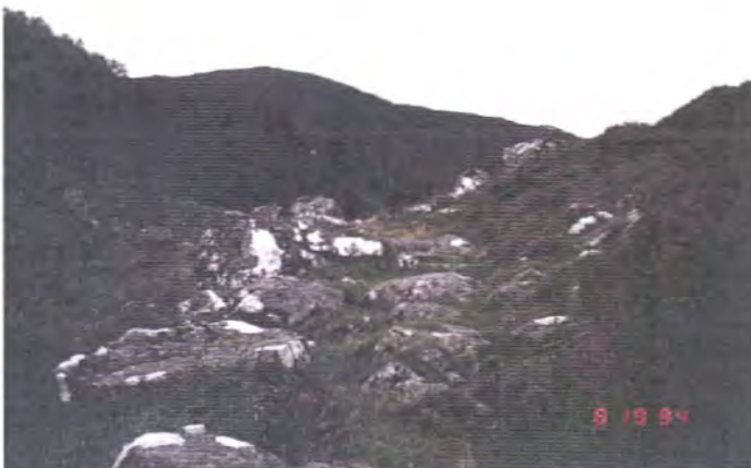
Vegen gjennom heia nord for Rimstad. Vegkantane er oppmurte. Mellom murane er vegbana svært nedsliten.
